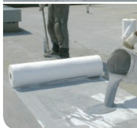
Nach ca. 30 Minuten ist die Abdichtung regenfest und nach ca. 72 Stunden ausgehärtet.
